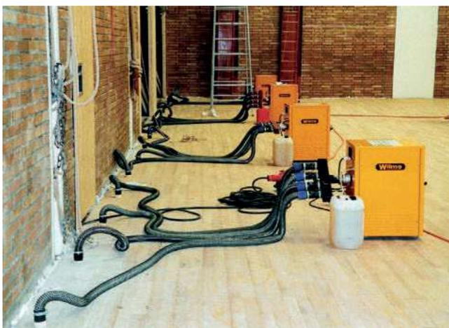
Unterstrichtrockner mit Geruchsverbesserer im Einsatz mit mehreren Geräten in Reihe
